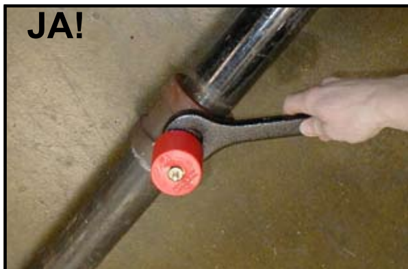
Afbeelding 1: Juist gebruik van de speciale montagesleutel (ESFR pendent K14 Sprinkler SIN VK500 getoond met beschermkap en sprinklersleutel 10285W/B )
