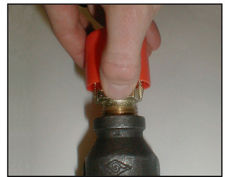
Abb.3: Die Schutzkappe wird von einem stehenden Sprinkler entfernt.
