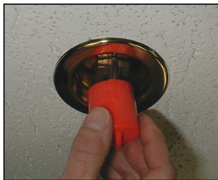
Abb.2: Die Schutzkappe wird von einem hängenden Sprinkler entfernt.
