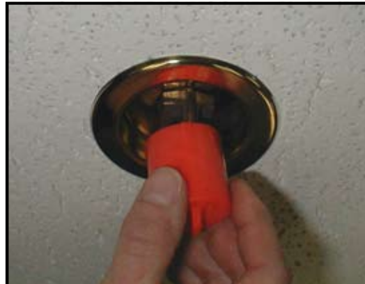
Afbeelding 2: Sprinklerkap wordt verwijderd van een pendent sprinkler.
