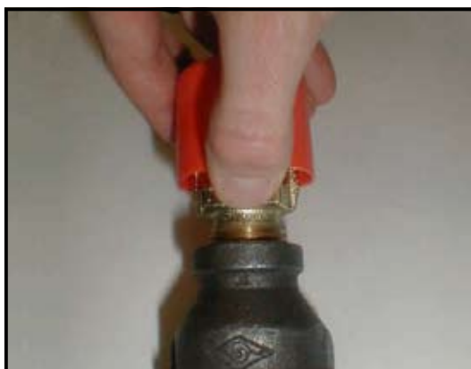
Afbeelding 3: Sprinklerkap wordt verwijderd van een upright sprinkler.
