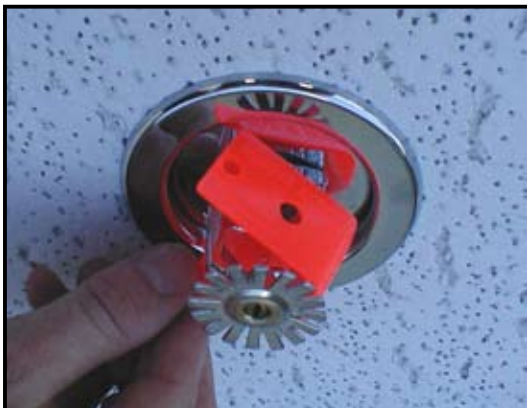
Afbeelding 1: Sprinkler shield wordt verwijderd van een pendent sprinkler.
