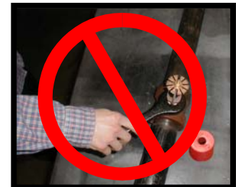
INCORRECTO! (montaje en el suelo)
