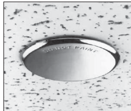
Sprinkler nascosto pendent Viking Horizon® Mirage® installato in un soffitto acustico
