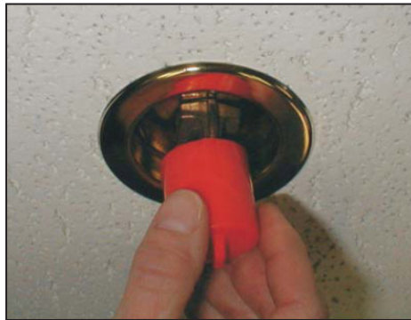
Bild 2 : Sprinklerkåpan tas bort från en nedåtriktad sprinkler.
