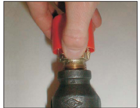
Bild 3 : Sprinklerkåpan tas bort från en uppåtriktad sprinkler.
