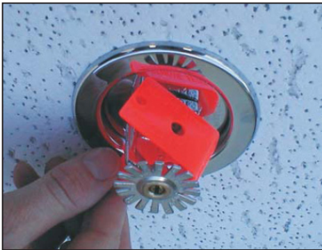
Bild 1 : Sprinklerskyddet tas bort från en nedåtriktad sprinkler.
